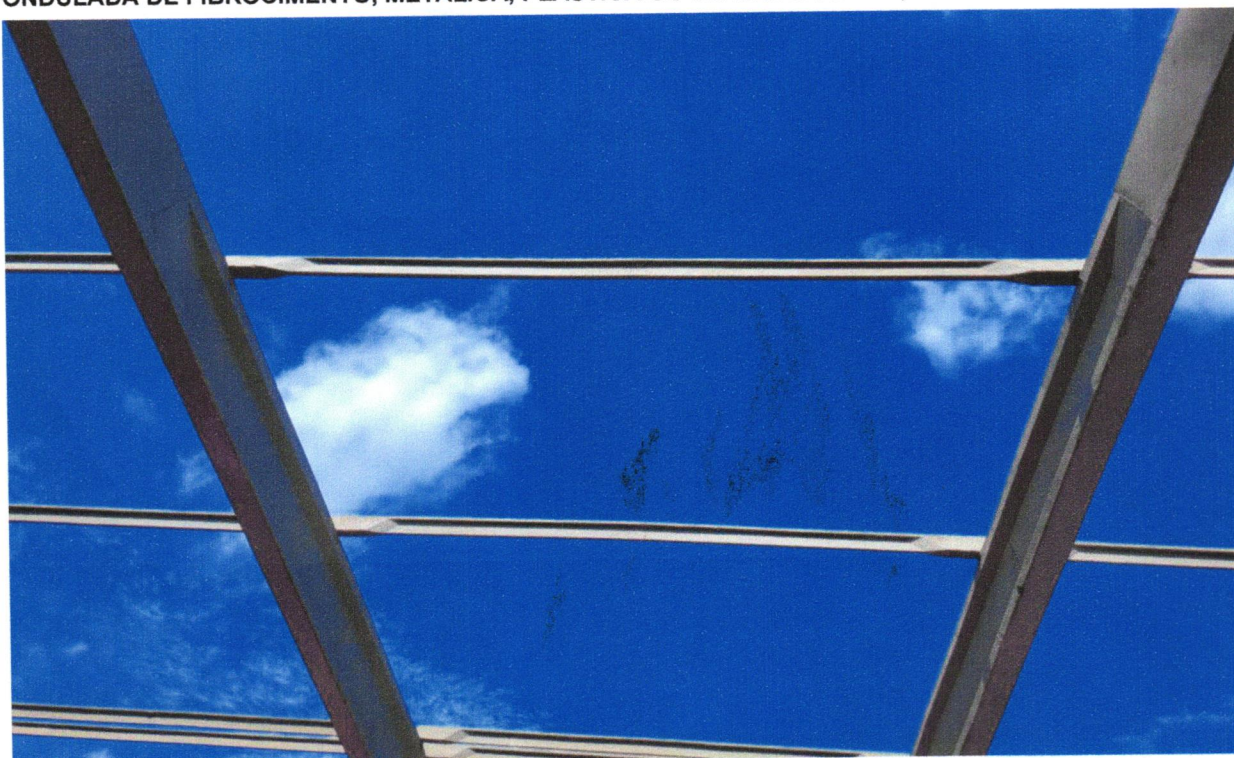
FOTO 16 - TRAMA DE AÇO COMPOSTA POR TERÇAS PARA TELHADOS DE ATÉ 2 ÁGUAS PARA TELHA ONDULADA DE FIBROCIMENTO, METÁLICA, PLÁSTICA OU TERMOACÚSTICA, INCLUSO
