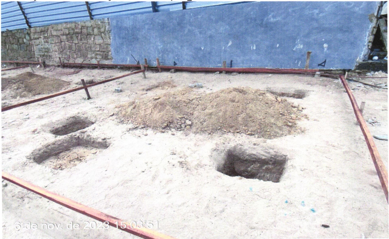
FOTO 22 - ESCAVAÇÃO MECANIZADA PARA VIGA BALDRAME COM MINI-ESCAVADEIRA (INCLUINDO ESCAVAÇÃO PARA COLOCAÇÃO DE FÔRMAS). AF_06/2017
