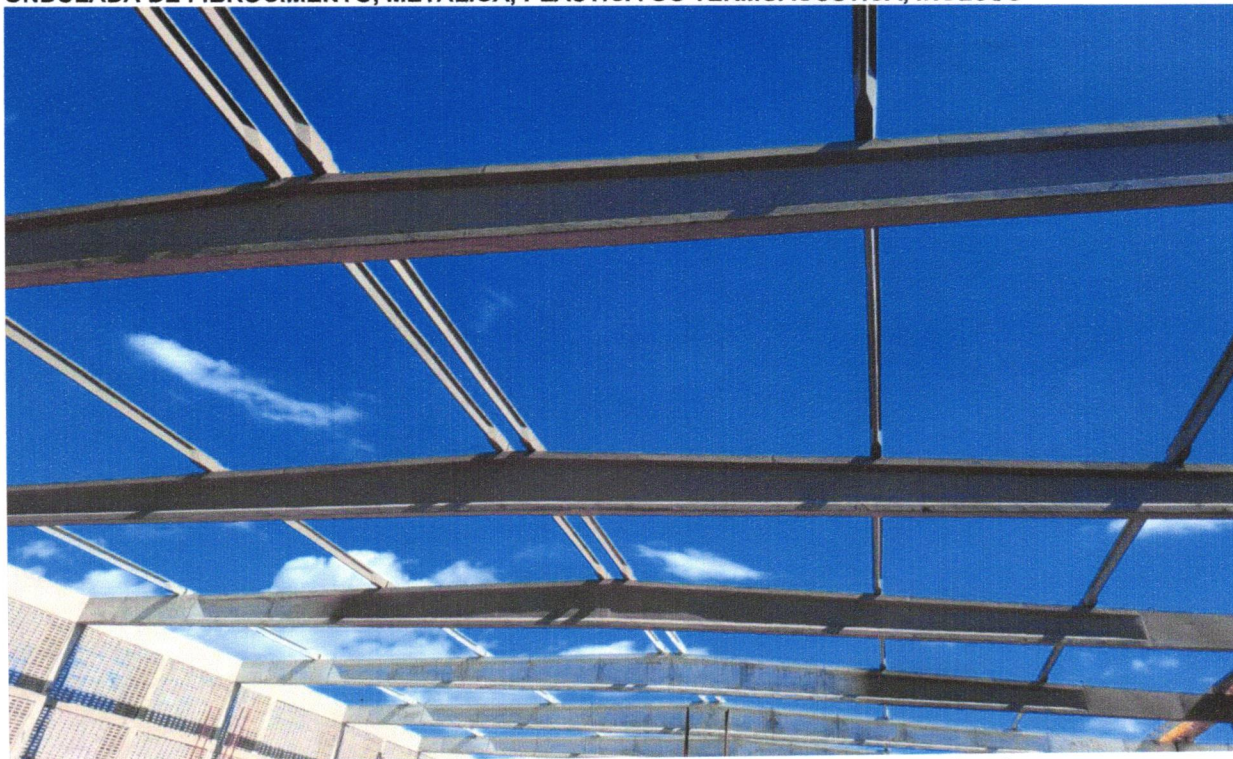
FOTO 16 - TRAMA DE AÇO COMPOSTA POR TERÇAS PARA TELHADOS DE ATÉ 2 ÁGUAS PARA TELHA ONDULADA DE FIBROCIMENTO, METÁLICA, PLÁSTICA OU TERMOACÚSTICA, INCLUSO
